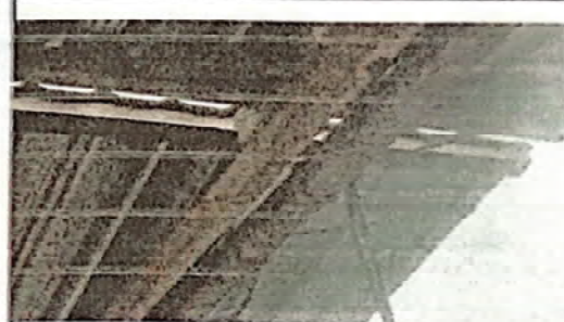
Foto 2: Sustitución de lamina por lamina troquelado aluzinc calibre 26 (14 pies)
